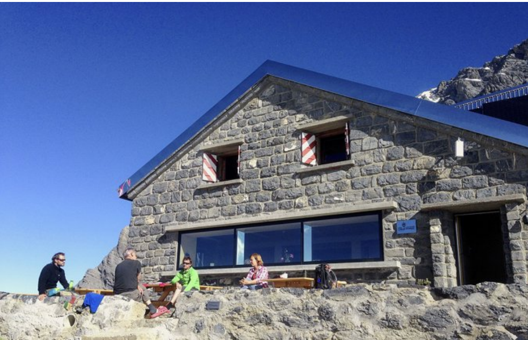
La façade sud en moellons du bâtiment de 1952 a été percée d’une large baie vitrée.
