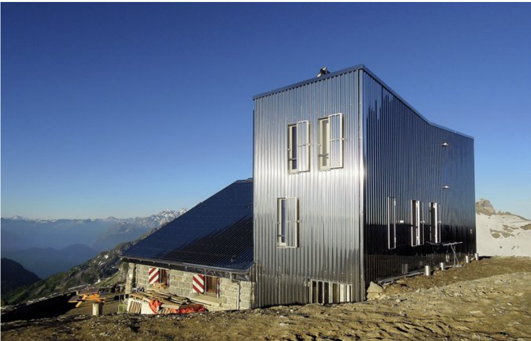
Le «sac à dos» moderne recouvert de tôle inox concentre sanitaires et parties techniques.
